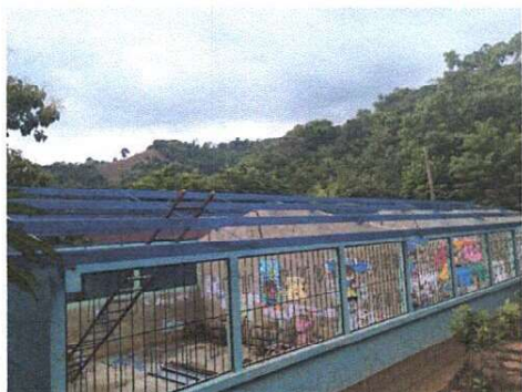
Foto 3: Etapa de pintura y finalizacion de juntas de refuerzos de las tijeras y costaneras de las aulas del centro educativo del modulo 2
