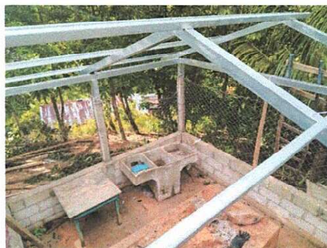
Foto 4: Cambio de techado, colocación de tijeras y costaneras de la cocina escolar del modulo 3
