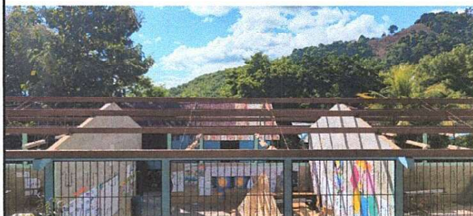
Foto 2: Limpieza y refuerzos para costaneras del modulo 1
