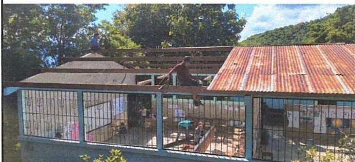
Foto 1: Desmontaje de laminas para su posterior cambio del modulo 1
