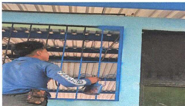
Foto 6: Mantenimiento de valcones de las aulas, colocacion de pintura anticorrosiva del modulo 2
