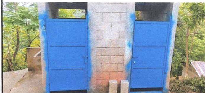
Foto 5: Mantenimiento de puertas y puesta de recubrimiento de pintura anticorrosiva de baño del centro educativo del modulo 2
